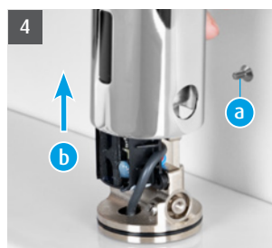
4. Sicherungsschraube auf der Rückseite der Armatur lösen und Armaturenhaube nach oben abziehen.
