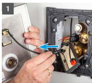
1 Infrarot-Sensor, Magnetventil und Spannungsversorgung vom Elektronikmodul abstecken.
