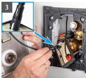
Steckverbindung von Infrarot-Sensor und Elektronikmodul herstellen (auf Markierungen achten). Anschließend weitere Montage durchführen (**siehe Seite 11**).
