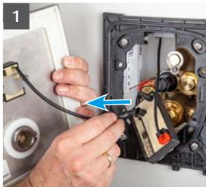
Infrarot-Sensor vom Elektronikmodul abstecken.
